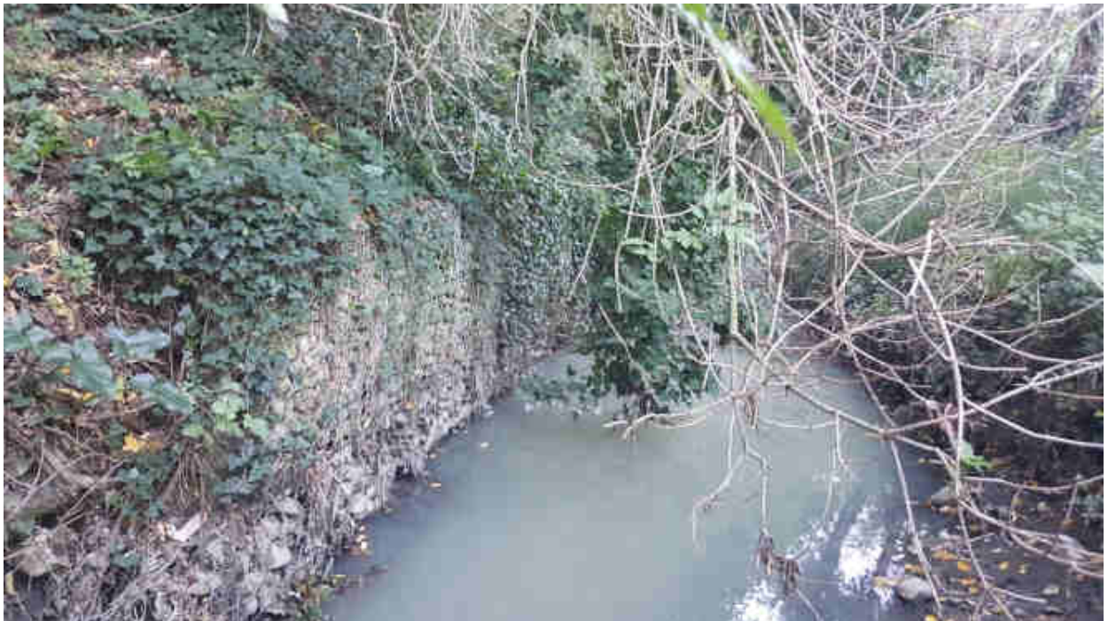
Figura 5.1 Foto della Gabbionata al piede della scarpata torrentizia, in destra idrografica, nel tratto prospiciente la proprietà.
