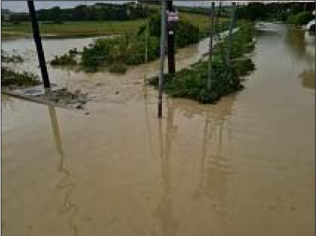
Figura 3-10: Esondazione del Fosso Re dei Gatti all'incrocio tra l'omonima via e la strada Montefeltro.
